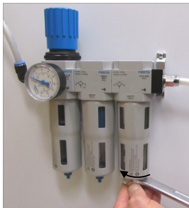
Рис. 7. Снятие корпуса газового фильтра генератора азота
